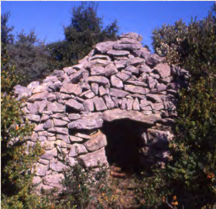
3 Le Dévès. Cabane circulaire, à voûte prononcée, adossée à un large mur.
