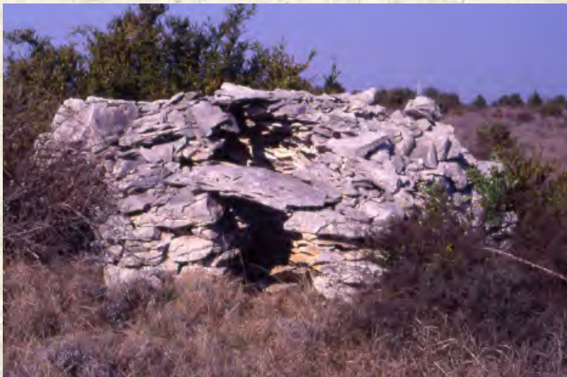
23 Berc / Les Grès. Cabane isolée, avec sa voûte effondrée, aujourd'hui détruite.
