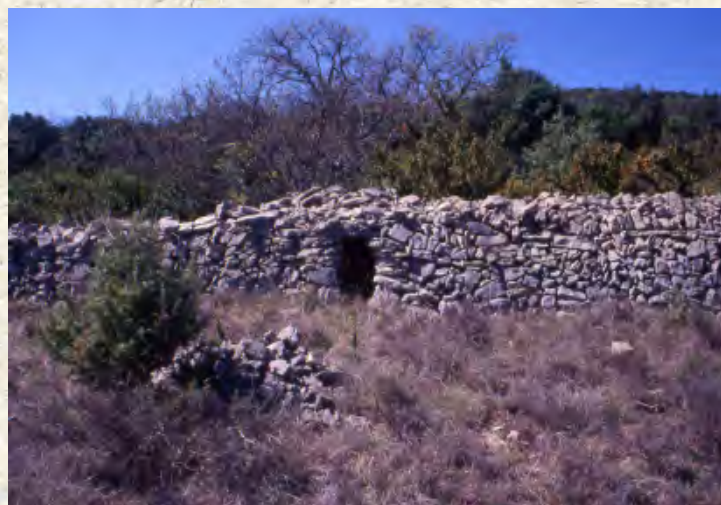
13 Costes chaudes. Cabane incluse dans un mur.
